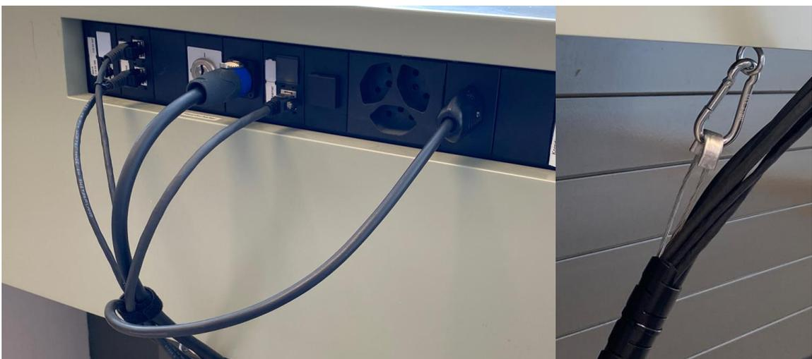
Bild: Anschlusspunkt mit Arretierung
